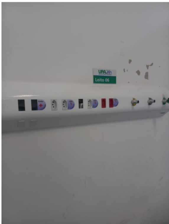
13/11 – Manutenção réguas dos leitos M6
