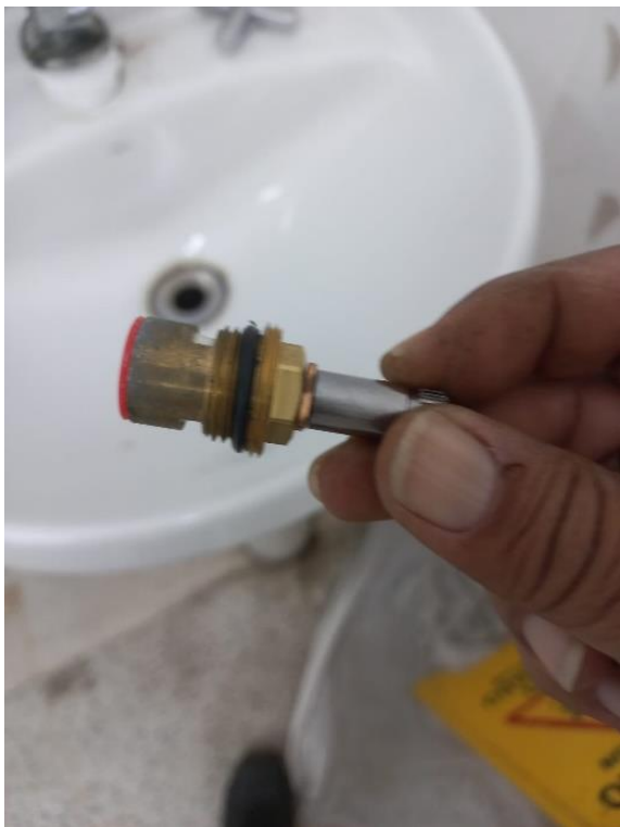
04/11 - Substituição registro de abertura de água classificação de risco 3
