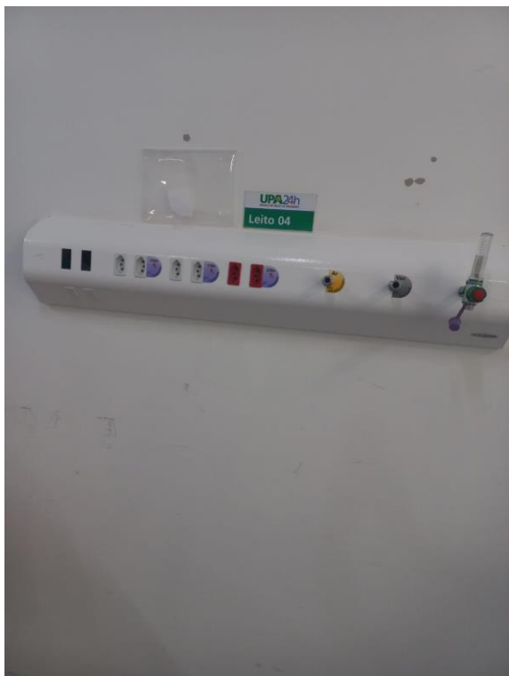
13/11 – Manutenção réguas dos leitos M4
